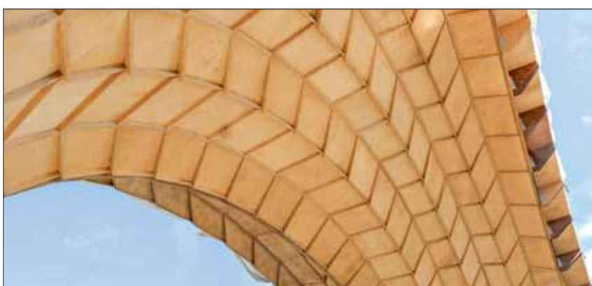
Bei der Mehrzweckhalle der Schreinerei Annen Plus SA in Manternach (Luxemburg) werden mit vergleichsweise kleinen Holzteilen große Spannweiten überbrückt. Foto: Ibois/EPFL
