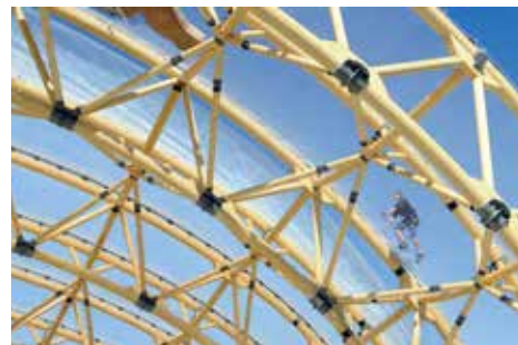
Centre « Vitam'Parc », Neydens (France), 2009. Portée maximale des arcs triangulés à 2 articulations de 43 m (Photo : © Corinne Cuendet, Clarens/LIGNUM)
